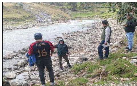
Figura 1. Muestra la ribera erosionada junto a la infraestructura cercada, del estadio municipal. La proximidad del río al muro representa un riesgo potencial por socavación, especialmente en épocas de crecida, comprometiendo la estabilidad del terreno y la seguridad de la infraestructura cercana.
