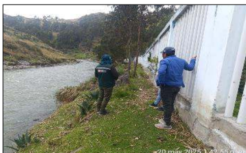
Figura 1. Muestra la ribera erosionada junto a la infraestructura cercada, del estadio municipal. La proximidad del río al muro representa un riesgo potencial por socavación, especialmente en épocas de crecida, comprometiendo la estabilidad del terreno y la seguridad de la infraestructura cercana.
